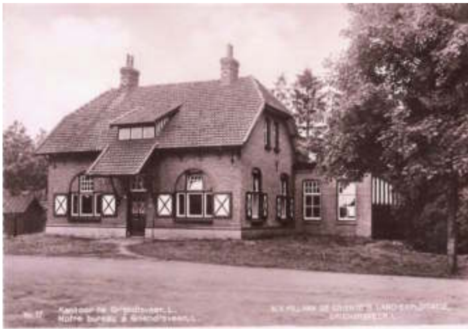
Kantoor in Griendtsveen
